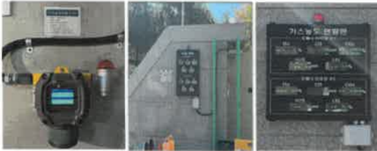
오폐수처리장 복합가스측정기 설치
